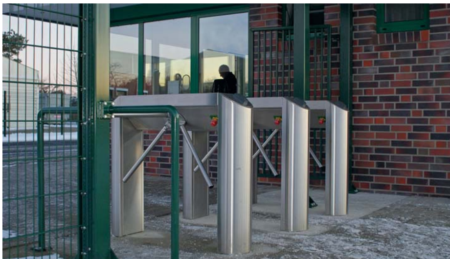
Diebstahlprävention gegen Inventurdifferenzen: Personenvereinzelnungsanlage mit Zufallsgeneratoren zur Taschenkontrolle.
